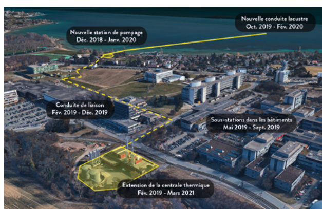
Fig. 1 Vue d'ensemble du chantier
